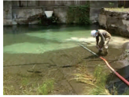
写真6 水中施工時の様子 Photo 6 Casting in water
