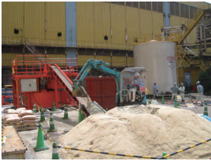
写真5 施工プラントの概観 Photo 5 Overview of mixing plants
